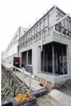
SJÓMINJASAFNIÐ Verið er að steypa gólf undir útsýnispál.
